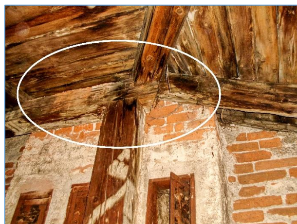
Obr.č. 4 – LOKALITA 2 - DETAIL BIOTICKÉ DESTRUKCE KONSTR.SPOJE - INDEX D
