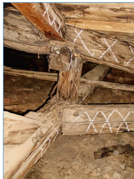
Obr.č. 14 – LOKALITA 4 - DETAIL BIOTICKÉ DESTRUKCE ÚŽLABNÍ KONSTR. SPOJ + PATNÍ ČÁST ÚŽLABNÍ KROKVE - INDEX D (SMĚR Z PŘÍCHODOVÉ STRANY)
