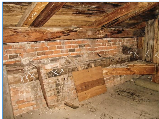
Obr.č. 30 – LOKALITA 10 – POKRAČIJÍCÍ BIOTICKÁ DESTRUKCE POZEDNICE INDEX D
