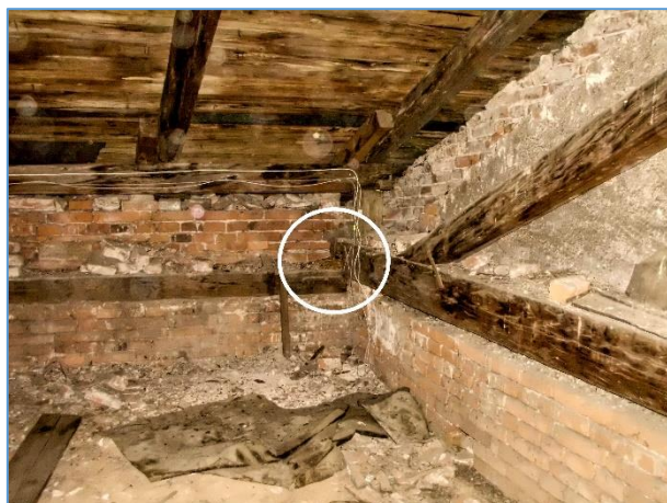
Obr.č. 1 – LOKALITA1 ULOŽENÍ ŠTÍTOVÉHO VT
