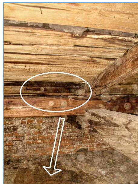
Obr.č. 10 – LOKALITA 5 - POHLED DO MÍSTA SILNÉHO ZATÉKÁNÍ DEŠŤOVÉ VODY POŠKOZENÝ STŘEŠNÍ PLÁŠŤ
