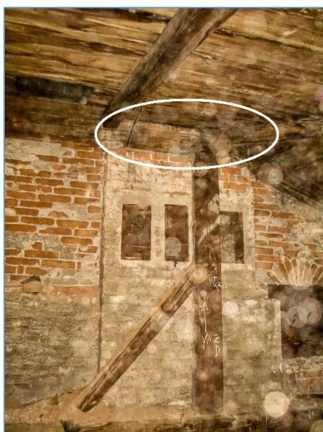
Obr.č. 3 – LOKALITA 2 ŠTÍTOVÁ VAZNICE A SLOUPEK + KROKEV
