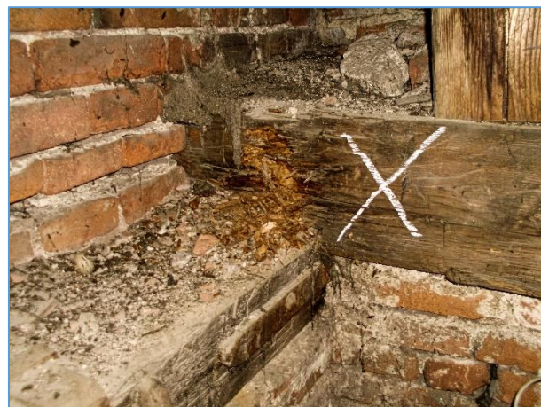
Obr.č. 2 – LOKALITA 1 - DETAIL BIOTICKÉ DESTRUKCE VT/POZEDNICE - INDEX D
