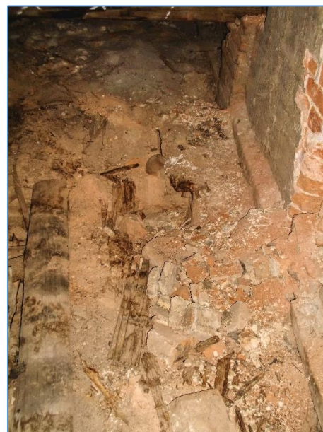
Obr.č. 16 – LOKALITA 4 – PATA KOM.TĚLESA – ROZPADLÉ DŘ. KCE
