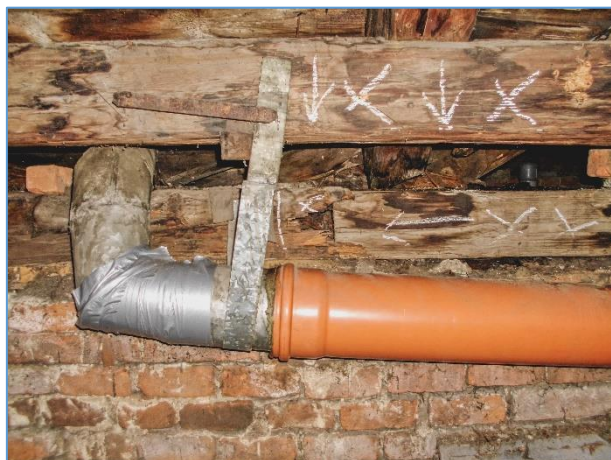
Obr.č. 33 – LOKALITA 11 – POLODETAIL HAVARIJNÍHO STAVU ÚŽLABNÍHO KONSTR. SPOJE
