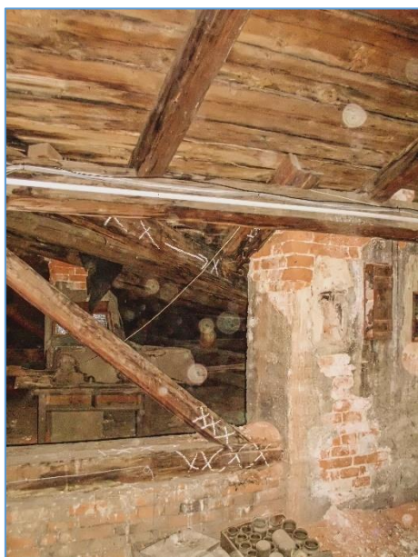
Obr.č. 19 – LOKALITA 4 – CELKOVÝ POHLED NA BIOTICKOU DESTRUKCI ÚŽLABNÍ KROKVE V PRŮBĚŽNÉ DÉLCE U KOMÍN. TĚLESA - INDEX D
