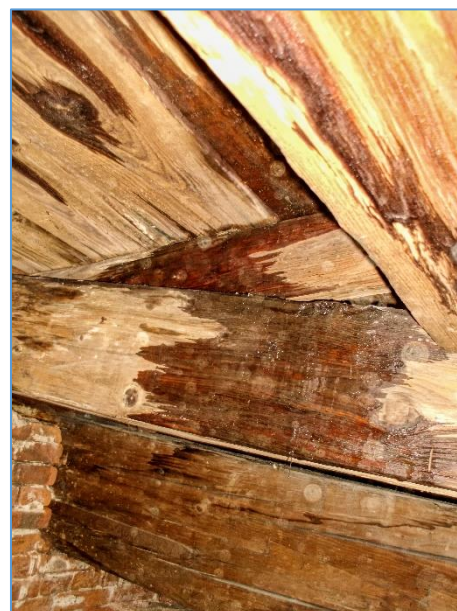
Obr.č. 8 – LOKALITA 5 - POHLED DO MÍSTA SILNÉHO ZATÉKÁNÍ DEŠŤOVÉ VODY
