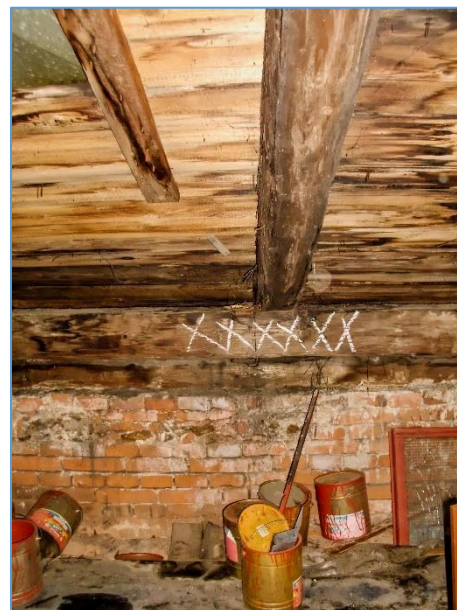
Obr.č. 22 – LOKALITA 7 – BIOTICKÁ DESTRUKCE POZEDNICE A STŘEŠNÍHO PODBITÍ - INDEX D
