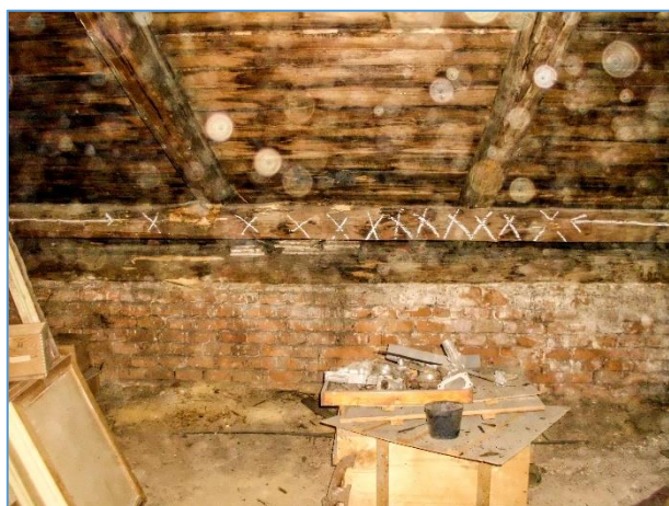
Obr.č. 35 – LOKALITA 11 – PROTILEHLÁ STRANA – TOTÁLNÍ DESTRUKCE POZEDNIC LARVAMI DŘ. HMYZU INDEX D
