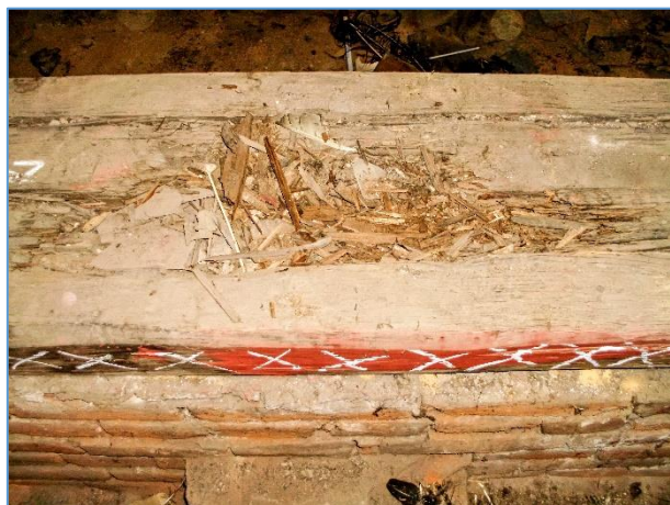
Obr.č. 21 – LOKALITA 6 – TOTÁLNÍ BIOTICKÁ DESTRUKCE VAZNÍHO TRÁMU INDEX D
