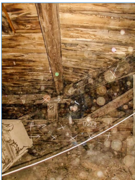
Obr.č. 11 – LOKALITA 4 ÚŽLABNÍ KONSTR. SPOJ + ÚŽLABNÍ KROKEV V CELÉ DÉLCE A PŘÍLEHLÉ PRVKY
