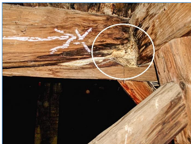
Obr.č. 17 - LOKALITA 4 – OBLAST KOMÍNOVÉHO TĚLESA – PLODNICE DŘEVOMORKY DOMÁCÍ
