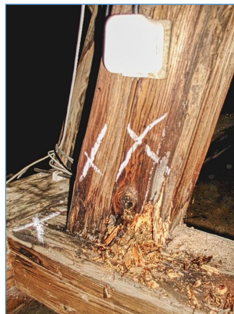
Obr.č. 6 – LOKALITA 3 - DETAIL BIOTICKÉ DESTRUKCE KONSTR.SPOJE - INDEX D
