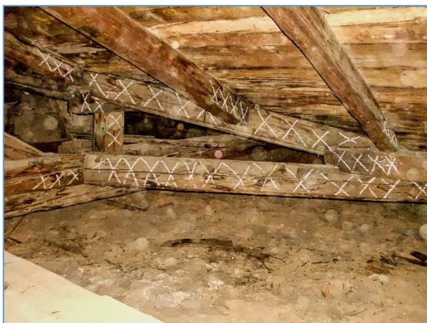
Obr.č. 13 – LOKALITA 4 – CELKOVÝ POHLED NA BIOTICKOU DESTRUKCI ÚŽLABNÍ KONSTR. SPOJ + PATNÍ ČÁST ÚŽLABNÍ KROKVE - INDEX D (SMĚR Z PŘÍCHODOVÉ STRANY)
