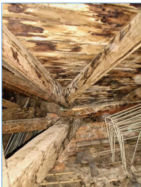
Obr.č. 47 – LOKALITA 13 CELKOVÝ POHLED NA ÚŽLABNÍ KONSTR. SPOJ INDEX D SMĚR KE SCHODIŠTI, VČ. POZEDNICE INDEX C SMĚR OD SCHODIŠTĚ
