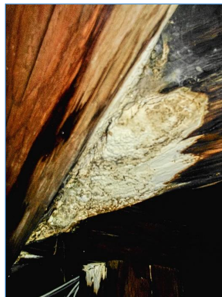
Obr.č. 18 – LOKALITA 4 – OBLAST KOMÍNOVÉHO TĚLESA – PLODNICE DŘEVOMORKY DOMÁCÍ – ODBĚR VZORKU VZ1
