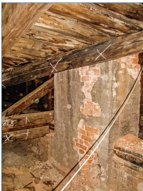
Obr.č. 15 – LOKALITA 4 - DETAIL BIOTICKÉ DESTRUKCE ÚŽLABNÍ KROKVE V PRŮBĚŽNÉ DÉLCE, VČ. HAVARIJNÍHO STAVU STŘEŠNÍHO PODBITÍ - INDEX D
