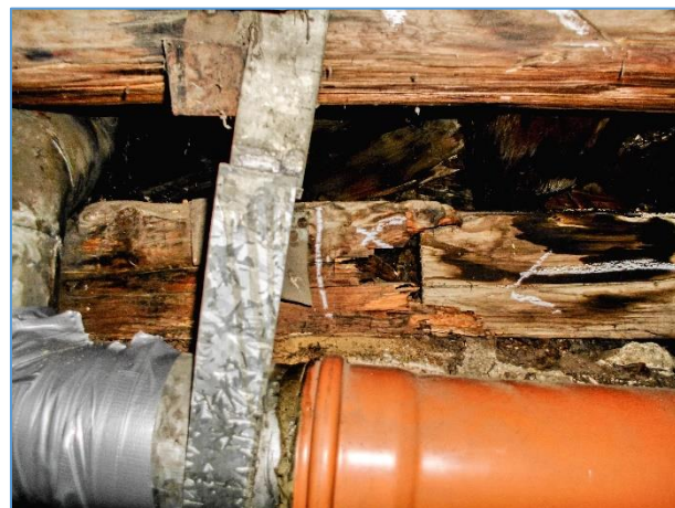
Obr.č. 34 – LOKALITA 11 – DETAIL HAVARIJNÍHO STAVU ÚŽLABNÍHO KONSTR. SPOJ - INDEX D ODBĚR VZORKU VZ3
