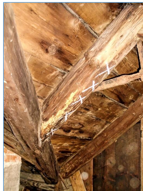
Obr.č. 26 – LOKALITA 9 – BIOTICKÁ DESTRUKCE KROKVIČKY LARVAMI DŘEVOKAZNÉHO HMYZU - INDEX D
