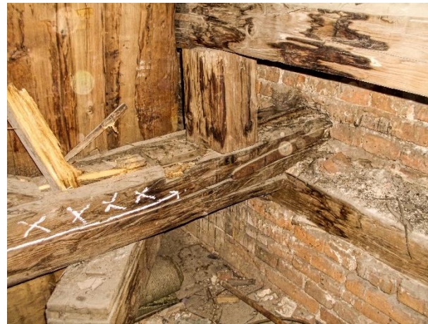
Obr.č. 28 – LOKALITA 10 – DETAIL TOTÁLNÍ BIOTICKÉ DESTRUKCE VT INDEX D
