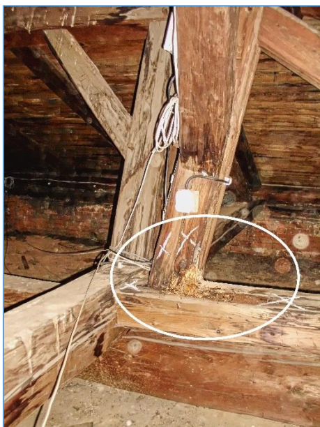
Obr.č. 5 – LOKALITA 3 PATNÍ ČÁST STOJINY LEŽATÉ STOLICE
