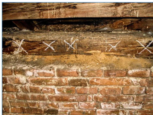
Obr.č. 46 – LOKALITA 12 DETAIL HAVARIJNÍHO STAVU POZEDNICE INDEX D
