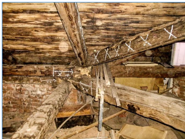
Obr.č. 23 – LOKALITA 8 – CELKOVÝ POHLED NA ÚŽLABNÍ KONSTR. SPOJ
