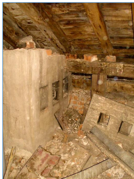
Obr.č. 40 – LOKALITA 11 – ZADNÍ PŮDNÍ PROSTOR VELKÉ MNOŽSTVÍ STAVEBNÍ SUTI
