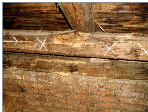
Obr.č. 36 – LOKALITA 11 – DETAIL PROTILEHLÁ STRANA – TOTÁLNÍ DESTRUKCE POZEDNIC LARVAMI DŘ. HMYZU - INDEX D
